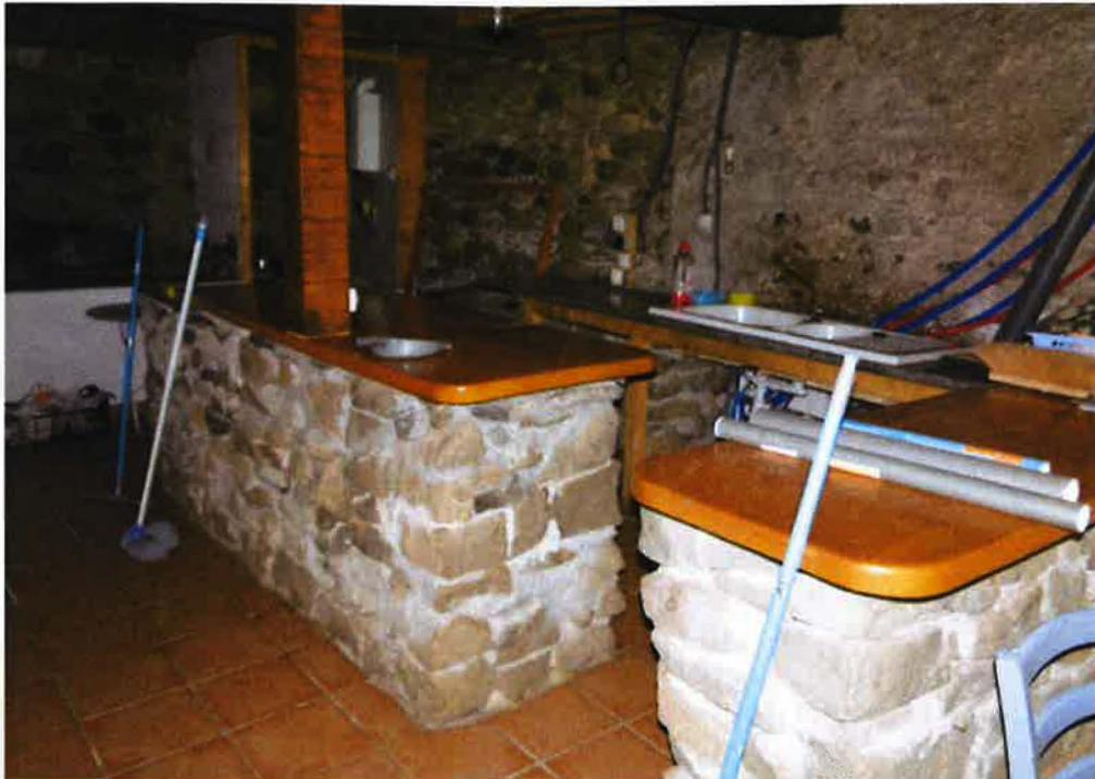
Contre le mur Nord, un plan de travail en mélaminé monté sur structure en bois au-dessus de piliers en pierres supporte un évier à deux bacs en bon état (photo ci-dessous).
