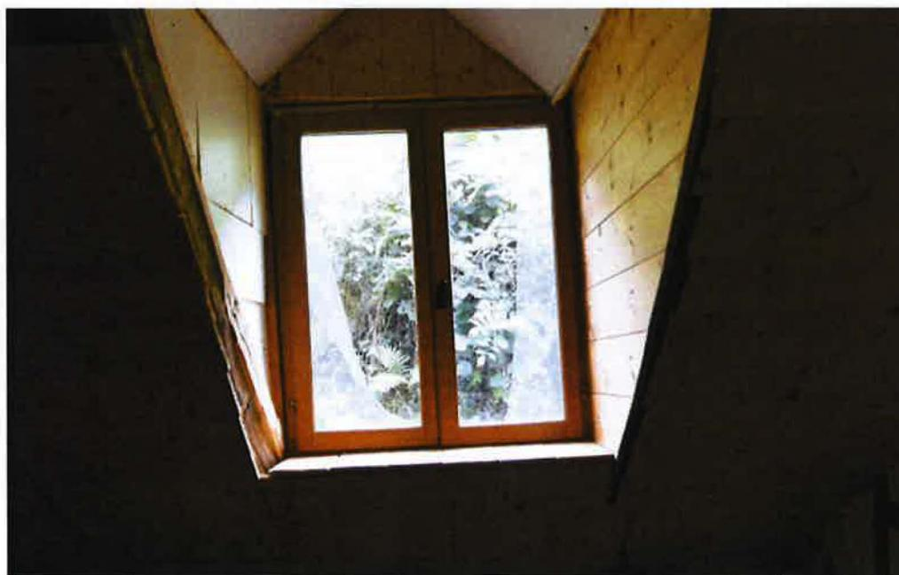
Côté Sud, un chien-assis grossièrement isolé et calfeutré s'ouvre sur le talus, il est équipé d'une menuiserie à double vitrage.
