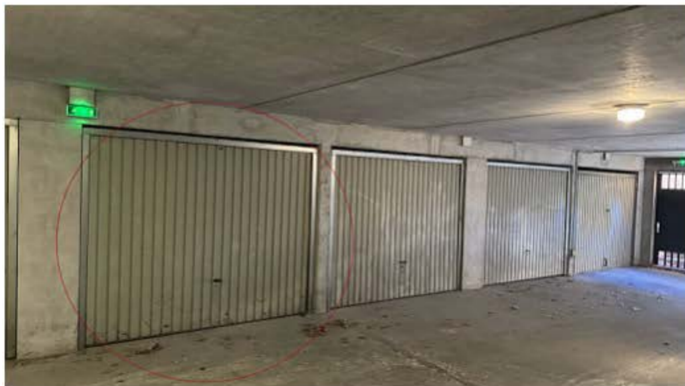
Photo 5 : Porte garage 36 (à gauche)
