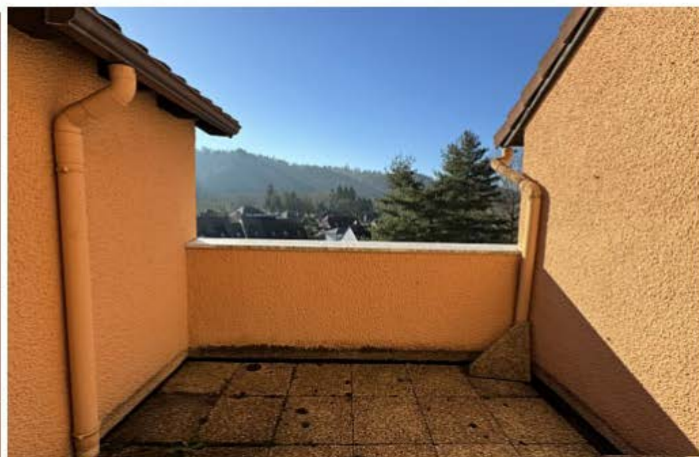
Photo 10 : Terrasse vers extérieur
