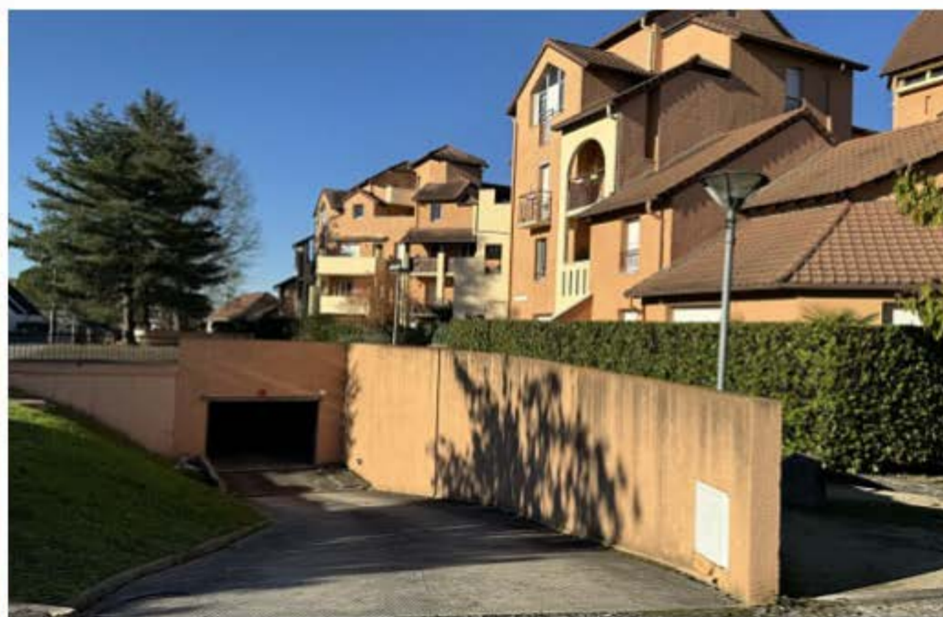
Photo 4 : Entrée parking souterrain
