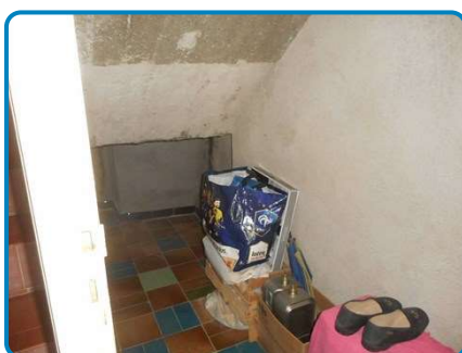
Rez de chaussée Placard sous escalier
