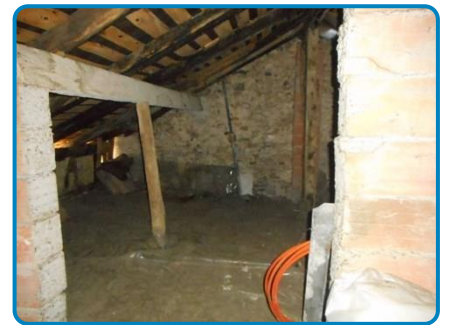
2ème étage Combles
