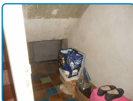
Rez de chaussée Placard sous escalier
