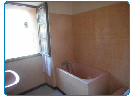
1er étage Salle de bains
